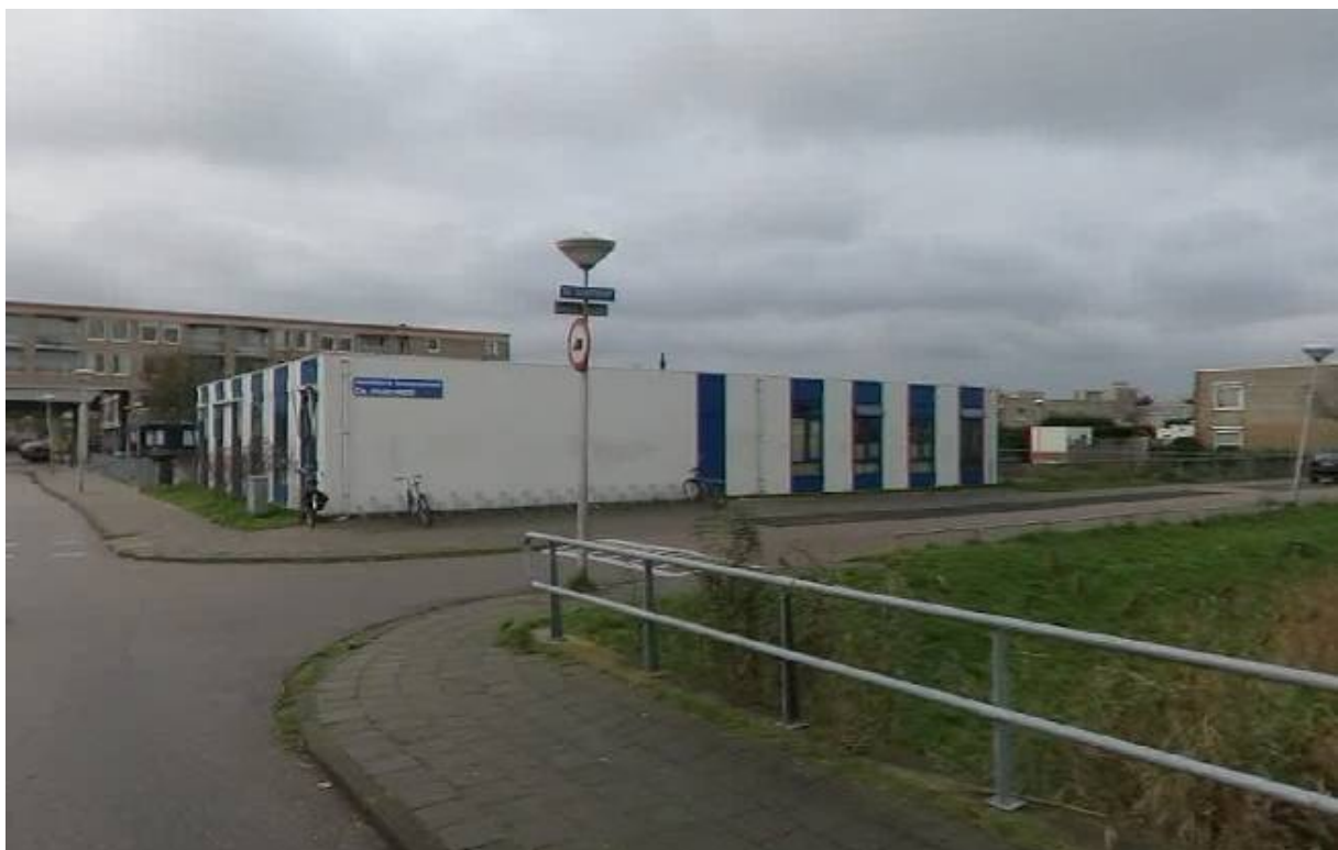
Afbeelding 8: locatie "de Molenweid" met tijdelijk schoolgebouw
